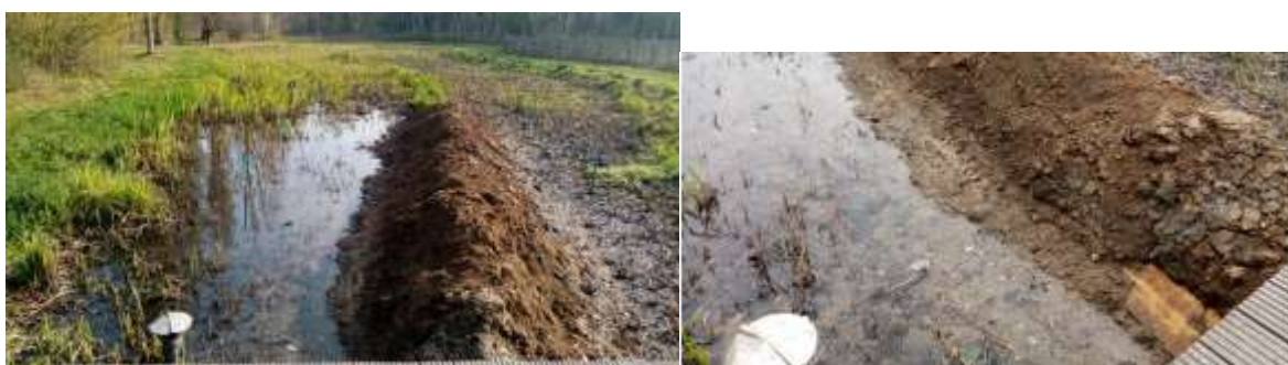
Figure 17: Reconstruction du merlon central dans la partie amont des filtres pour empêcher l'eau de passer d'un filtre à l'autre (28/03/2022).
