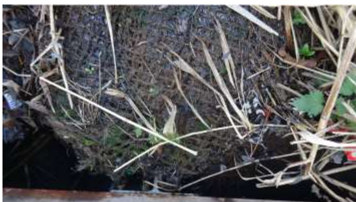
Figure 16: départ de la digue de séparation entre les filtres au niveau des regards de tranquillisation l'eau passe d'un filtre à l'autre (11/02/2022)
