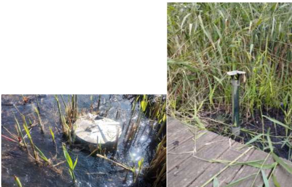
Figure 20: Cheminée d'aération sous l'eau à gauche et réhaussée ensuite à droite (livrable B1.4).
