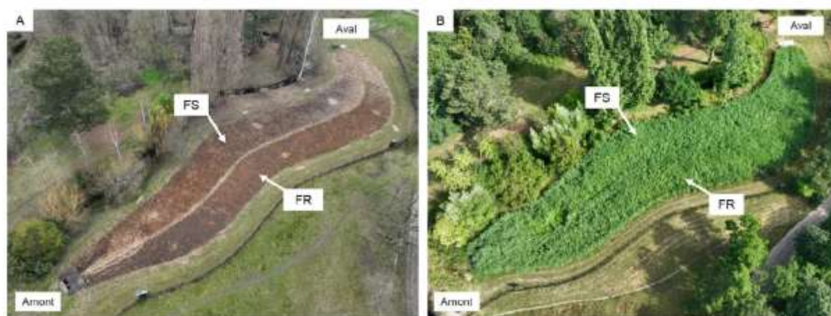
Figure 2: Le filtre planté de roseaux vu de haut (drone) en hiver (A) et en été (B). En regardant vers l'aval, le filtre traditionnel à sable (FS) est à gauche et le filtre innovant avec du Rainclean® (FR) est à droite (Crédit : Division Travaux et Environnement, Ville de Paris, 2023).
