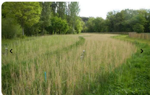
Filtre en fonctionnement dans le Bois de Boulogne après une alimentation - Crédits photo : Ville de Paris
