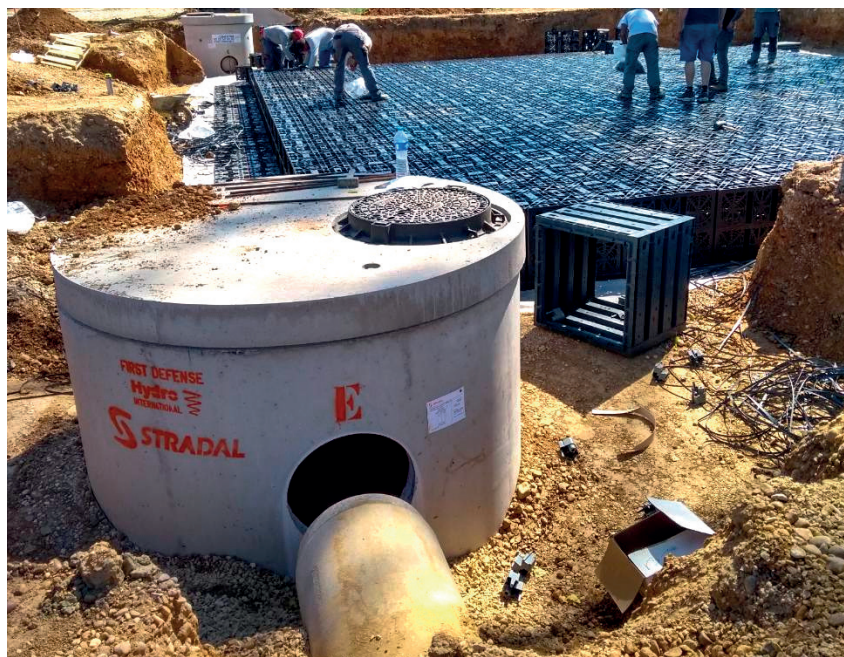
Le First Defense® de Stradal utilise les principes de rotation des fluides (décantation hydrodynamique) pour fournir une plus grande efficacité de captation des MES, comparées aux systèmes de traitement gravitaire. De plus, son bypass interne empêche la remise en suspension des polluants capturés lors des épisodes de pluies intenses.
