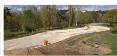
Les 2 filtres parallèles en cours de construction en avril 2019
