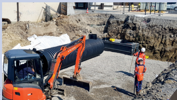
Chantier d'un bassin d'infiltration.
