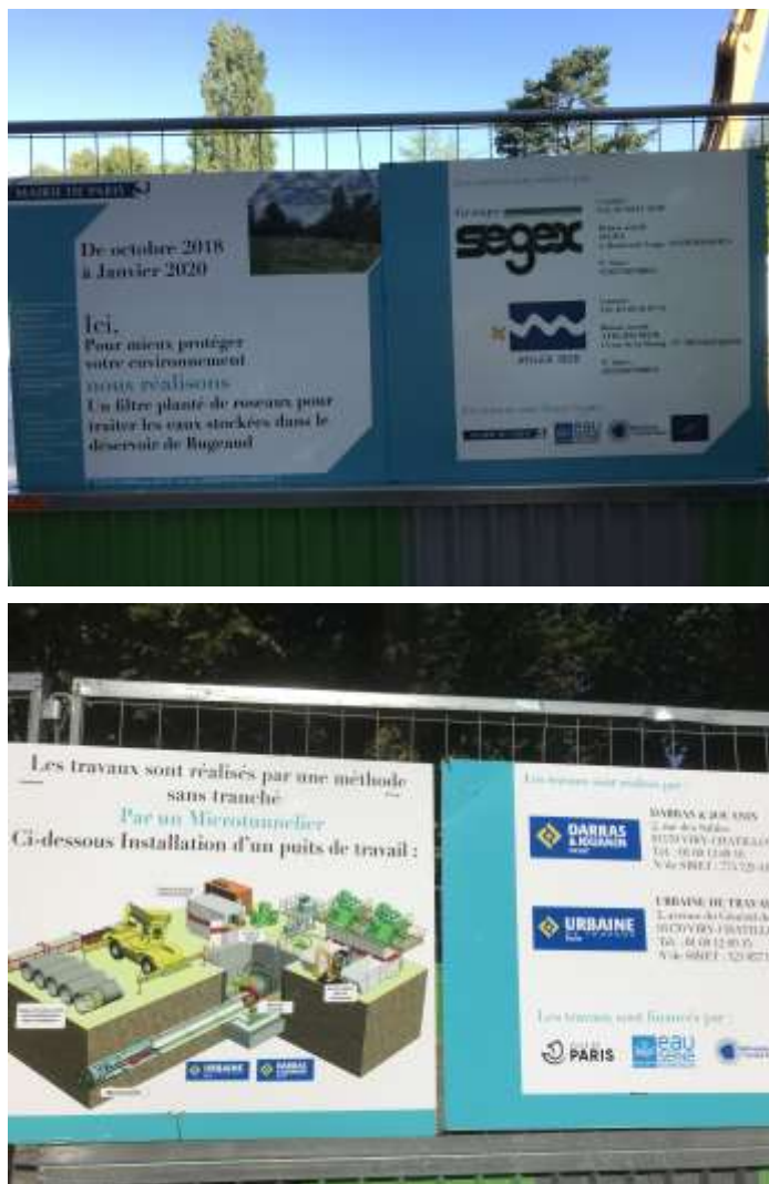
Figure 11 - Communication autour du chantier
