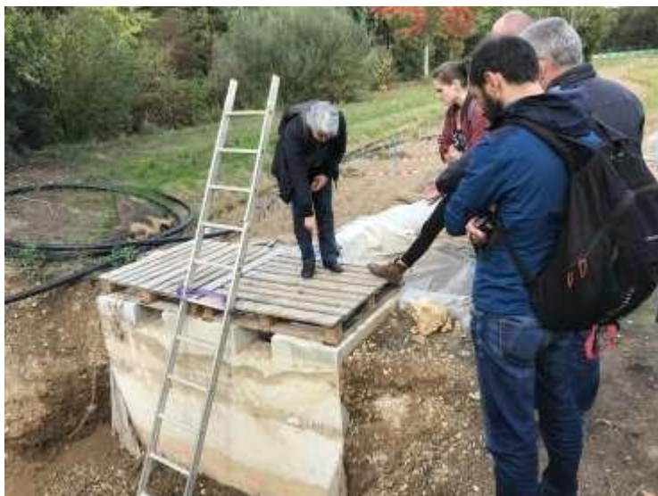
Figure 12 - Chercheurs et représentants de la mairie de Paris sur le chantier
