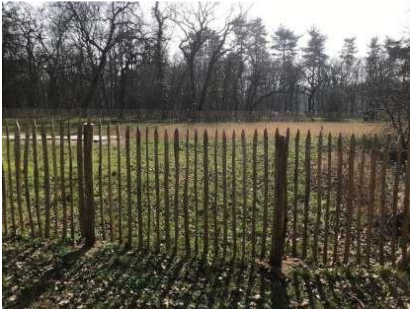
Figure 10 - Ganivelle ceignant le filtre planté
