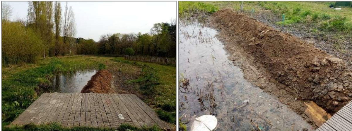
Figure 7. Photographies du remblai installé à l'entrée du filtre, entre les compartiments FS et FR entre les prélèvements T1 et T2
