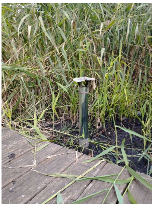
Figure 2 : Réhausse des cheminées d'aération
