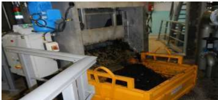
Figure 13 : Le dégrilleur
