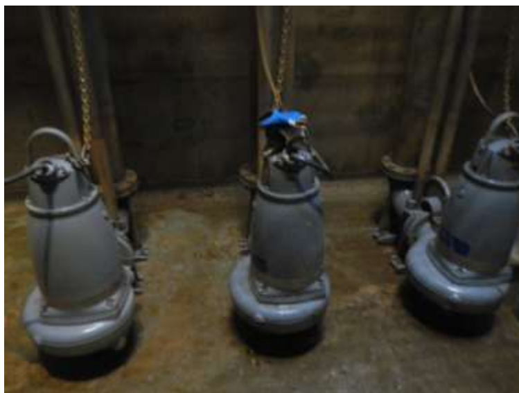
Figure 11 : Pompes d'alimentation
